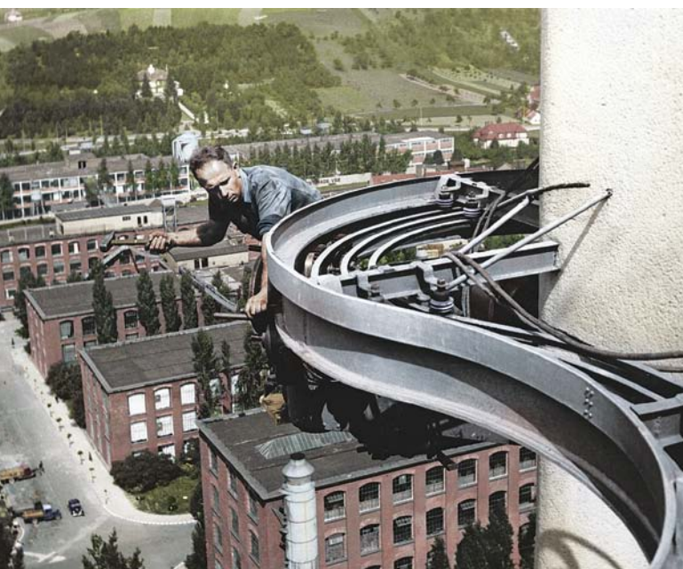
Výstavba 21. správní budovy/Construction of No. 21 Administration Building
